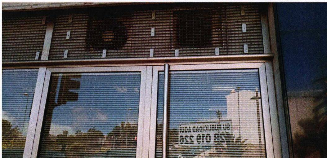
Vista del vestíbulo que se forma entre la puerta metálica exterior y la puerta exterior de la oficina. En ese vestíbulo se confina el aire caliente cuando está funcionando la instalación de aire acondicionado y la puerta metálica bajada.
