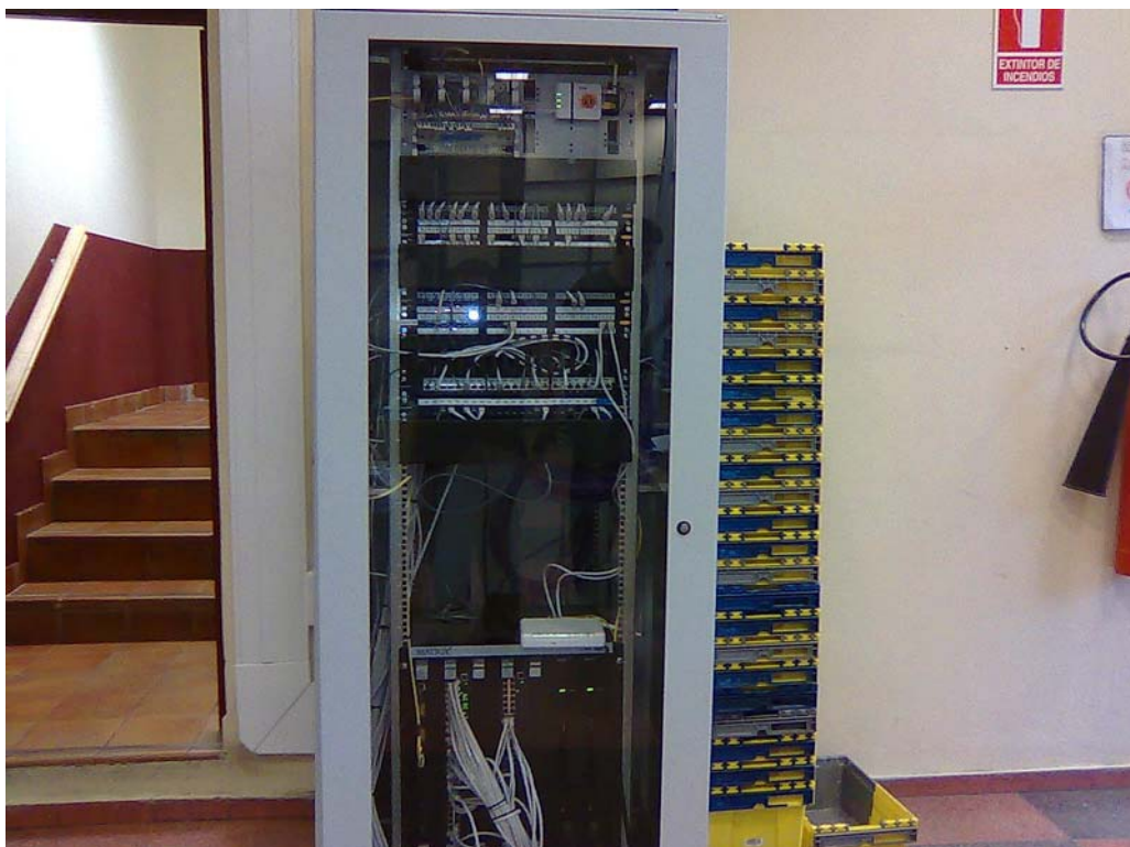
Foto 3: Rack de conexionado y electrónica de red
