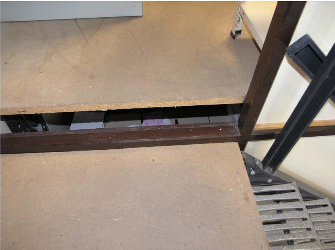
El cableado eléctrico de los puestos de trabajo provoca caídas al interceptar lugares de paso obligado.
